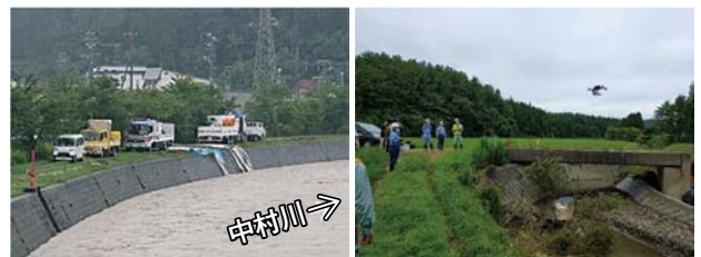
緊急排水状況（青森県）
