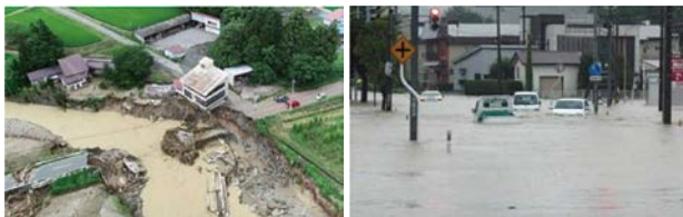
流出した大巻橋（山形県） 町中心部の浸水（青森県）
